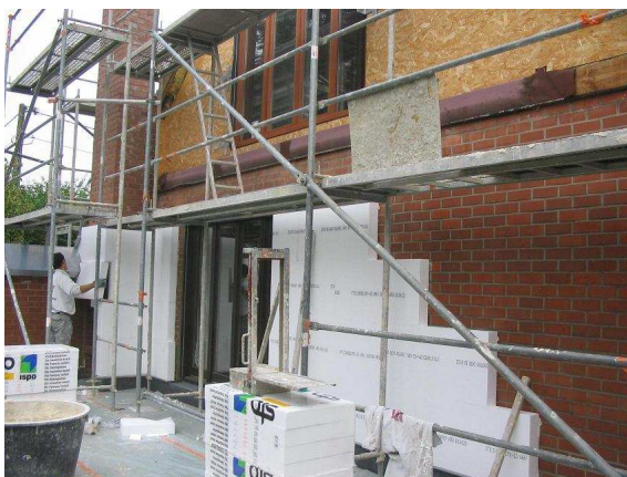
zijgevel, werk in uitvoering
